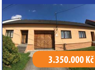
Zemědělská usedlost Uhřice
