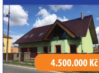
Novostavba RD Brankovice
