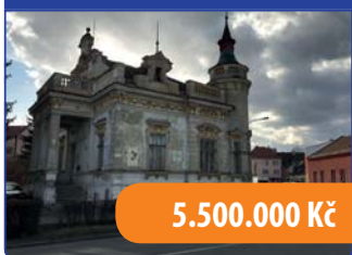
Polyfunkční objekt Vyškov
