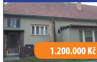
Venkovské stavení v obci Ludíkov
