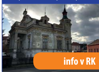
Polyfunkční objekt Vyškov
