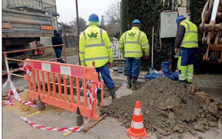
Oprava poruchy v Bořítově.
