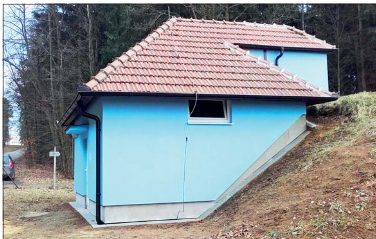
Společnost se také systematicky věnuje rekonstrukcím vodojemů v Blansku a okolí.
